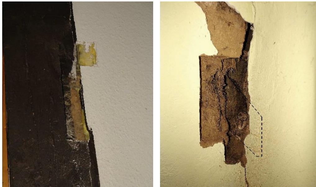
Abb. 39/40: Grünberg, Haus Barfüßergasse 5, Querschnitt QS1, Blattsassen der ehemaligen Kopfbänder an dem südöstlichen Bundständer - auf Augenhöhe im Bereich der heutigen Treppe zum OG (Ansicht von NW; Bild links) und unterhalb der Decke zwischen Ober- und Dachgeschoss (Ansicht von SW, durch schwarze Linie verstärkt; Bild rechts);
