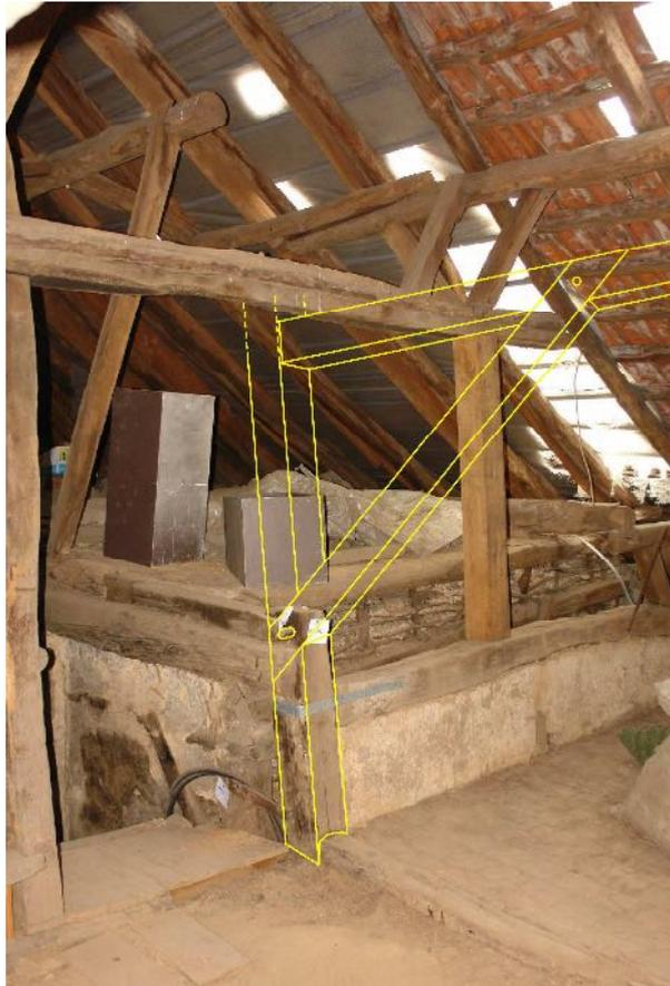
Abb. 34: Grünberg, Haus Barfüßergasse 5, Dachgeschoss, Rekonstruktion des Reststücks eines mutmaßlichen ehemaligen Firstständers der ursprünglichen Dachkonstruktion oberhalb der Süd-West-Wand der hinteren Zone (in Gelb), 1996 wohl noch vorhanden; Foto IBD, März 2016
