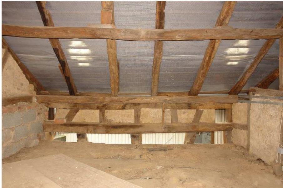
Abb. 33: Grünberg, Haus Barfüßergasse 5, Blick auf die südöstliche Traufwand im Bereich von Raum 3.1 des Dachgeschosses mit aufgedoppeltem Rähm zur Anhebung des sekundären Dachwerks;
