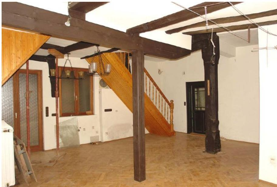
Abb. 22: Grünberg, Haus Barfüßergasse 5, zentrale Halle des Erdgeschosses (Raum 1.1) mit ursprünglicher Säule unter einem Mittellängsunterzug (im Bildhintergrund), Blick nach Süden; Aufnahme IBD, März 2016
