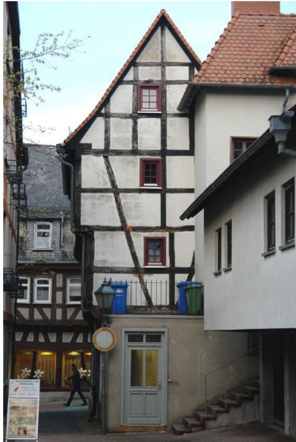
Abb. 5: Grünberg, Haus Marktgasse 8, rückwärtige Giebfassade mit über zwei Geschosse verlaufenden Langstreben als Queraussteifung; Aufnahme IBD, Oktober 2015
