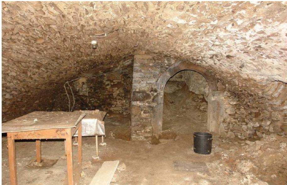
Abb. 14 u. 15: Grünberg, Haus Barfüßergasse 5, Gewölbekeller nach Nordosten (Bild oben) mit originaler, etwa halbrunder Gewölbekontur und nach Südwesten (Bild unten) mit starker Verformung beider Gewölberücken; Aufnahme IBD, September 2015
