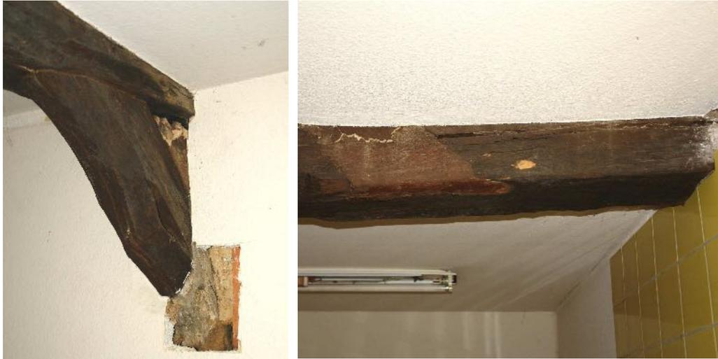
Abb. 43/44: Grünberg, Haus Barfüßergasse 5, Querschnitt QS2, oberer Binderbalken mit gezapftem Kopfband im Südosten (mit Freilegungsstelle im Ansatzbereich zum Bundständer; Bild links) und zugesetzter Blattsasse für ein ehemals aufgeblattetes Kopfband im Nordwesten (Bild rechts); Fotos IBD, März 2016
