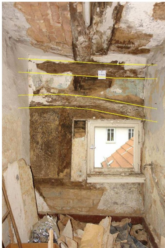
Abb. 32: Grünberg, Haus Barfüßergasse 5, Blick auf die nordwestliche Traufwand im Bereich von Raum 2.4 des Obergeschosses mit aufgedoppeltem Rähm zur Anhebung des sekundären Dachwerks (gelb hinterlegt); Fotos IBD, März 2016
