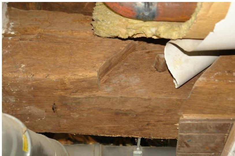
Abb. 42: Grünberg, Haus Barfüßergasse 5, Querschnitt 2, unterer Binderbalken mit Blattsasse für ein ehemaliges Kopfband mit Hakenblatt im Südosten; Foto IBD, März 2016
